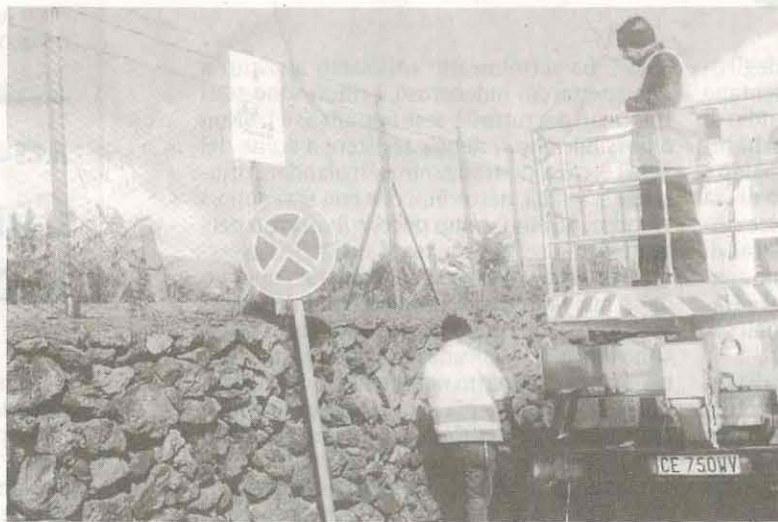
OPERAI AL LAVORO PER L'INSTALLAZIONE DELLE TELECAMERE
